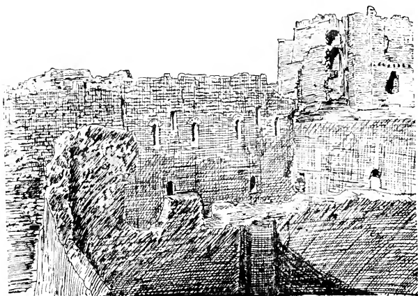
e déir Saint-Siméon à Assouan. — Les constructions de l'aile sud.
